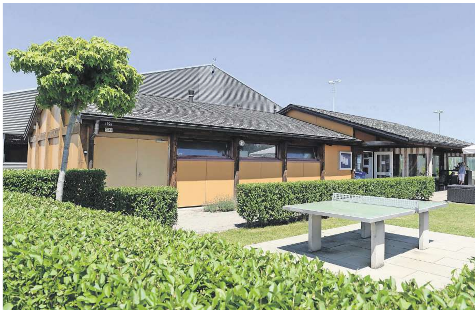
Das Klubhaus des Tennisvereins wird erneuert. Um die dafür notwendigen Investitionen abzusichern, erhofft sich der Verein ein neues Baurecht der Gemeinde Stäfa. Reto Schneider
